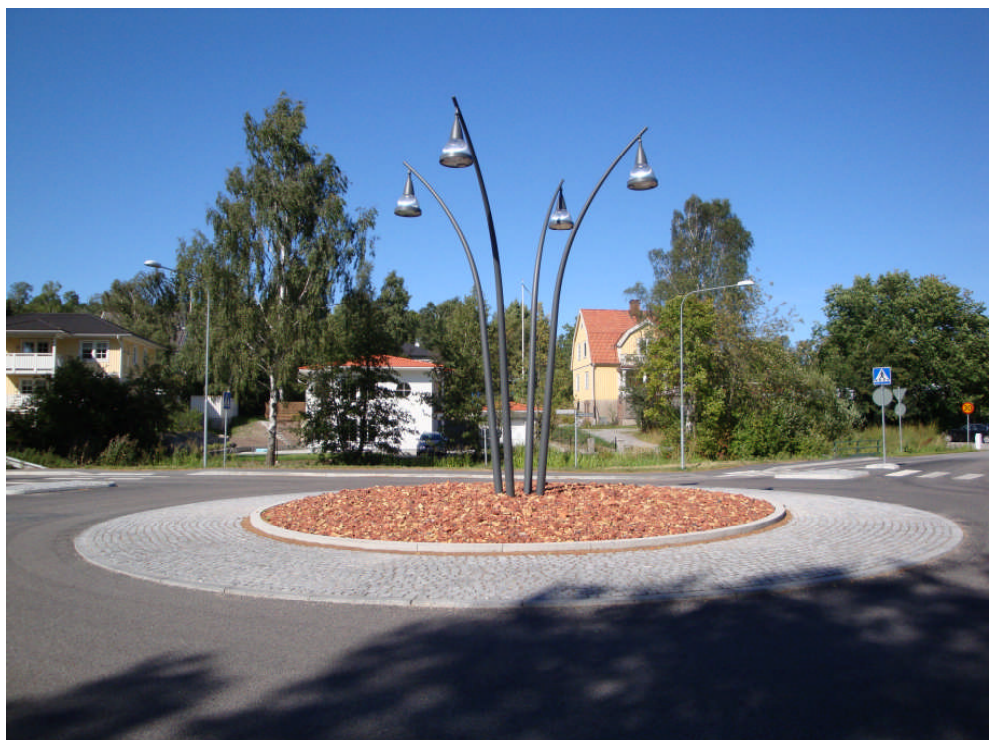
Cirkulationsplats vid Noragårdsvägen / Edsviksvägen
