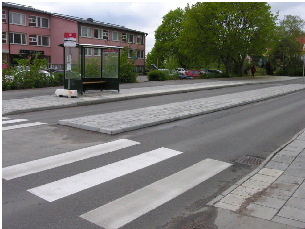
Nybyggd tillgänglig busshållplats vid Kevingeringen/ Edsviksvägen
